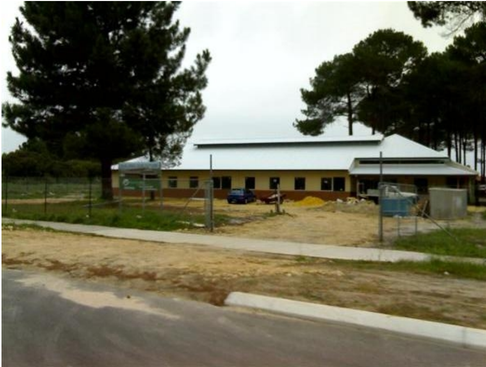
Lot 3398 Murray Street, Como - Sonshine FM Building
