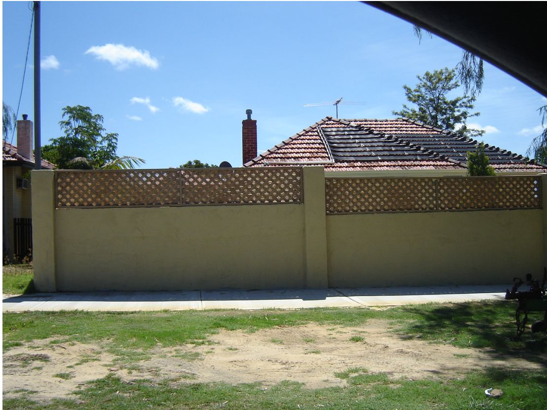
Photo 1- View from 49 Edgcumbe Street, Como
